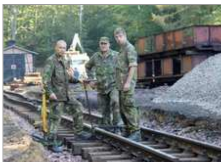
Auf dem Museumsbahnhof in Magdeburgerforth arbeiten 14 Soldaten des Baumaschinenzuges beim Gleisbau. | Foto: Bettina Schütze
