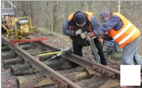
Mit vereinten Kräften versuchen hier Reinhard Knappe und Peter Hartung (v. re.) Schwellenschrauben reinzudrehen. | Foto: Bettina Schütze
